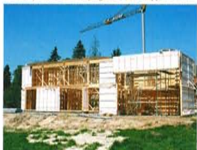
Chantier d'une maison à ossature bois
