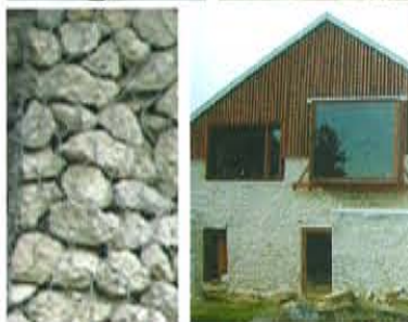
Matériaux : résilles métalliques pour plantes grimpantes, mur en gabion (caisson en treillage métal rempli de caillasse), pignon en moellon enduit à pierre vue et clinis de bois associés aux fenêtres cadrées
