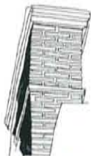
Souche de cheminée en brique rouge avec des cordons
