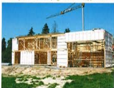
Chantier d'une maison à ossature bois
