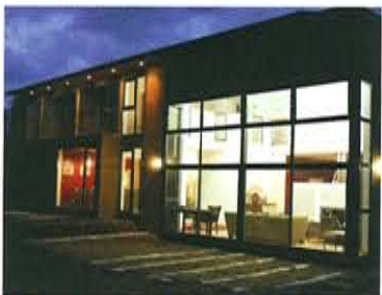
Construction avec installation d'un chauffage par géothermie (utilisation de l'énergie thermique du sol)
